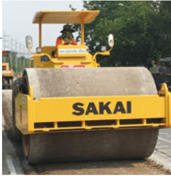
タイの工事風景：土工用振動ローラ
