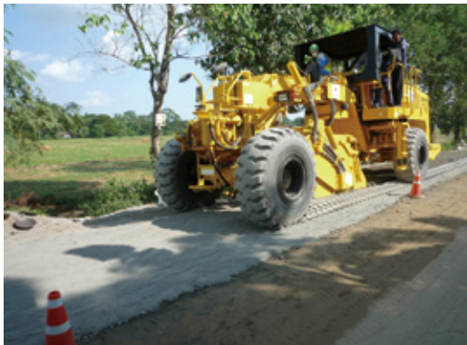
ミャンマーの工事風景：ロードスタビライザ
