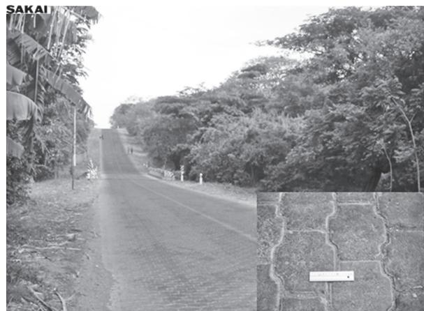
写真一 10 完成したインターロッキングブロック舗装
