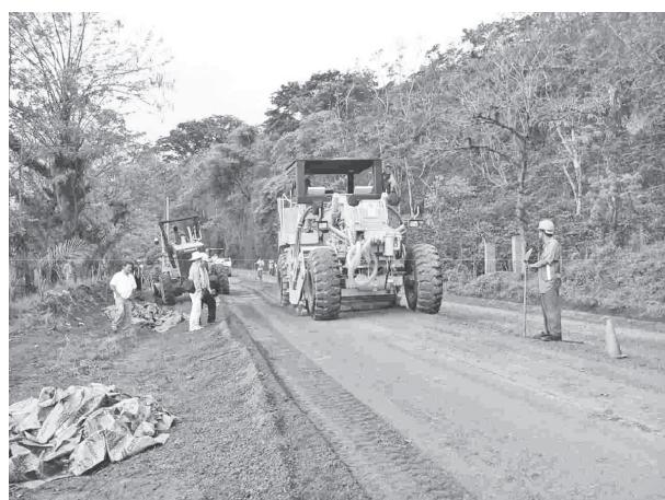
写真一 9 セメントによる処理
