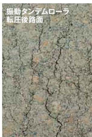
図6 RCCP におけるヘアークラックの接着効果
