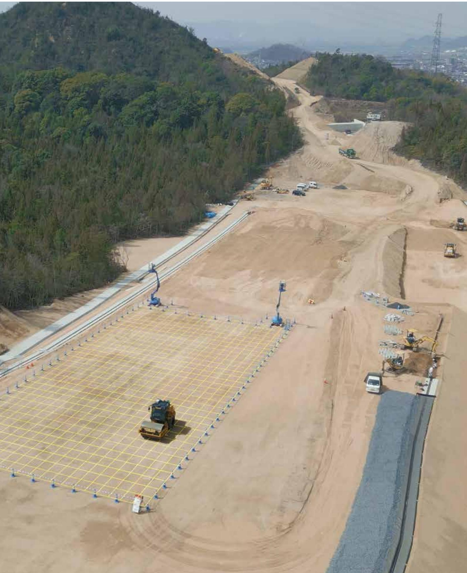
岡山県 国道 2 号玉島・笠岡道路工事現場（自動運転ローラー稼働中）
