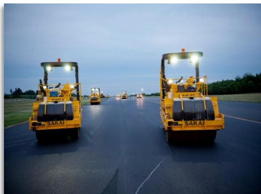
米国の高速道路舗装工事
