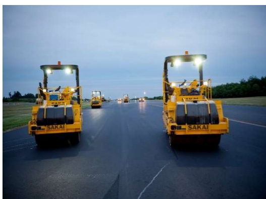
米国の高速道路舗装工事
