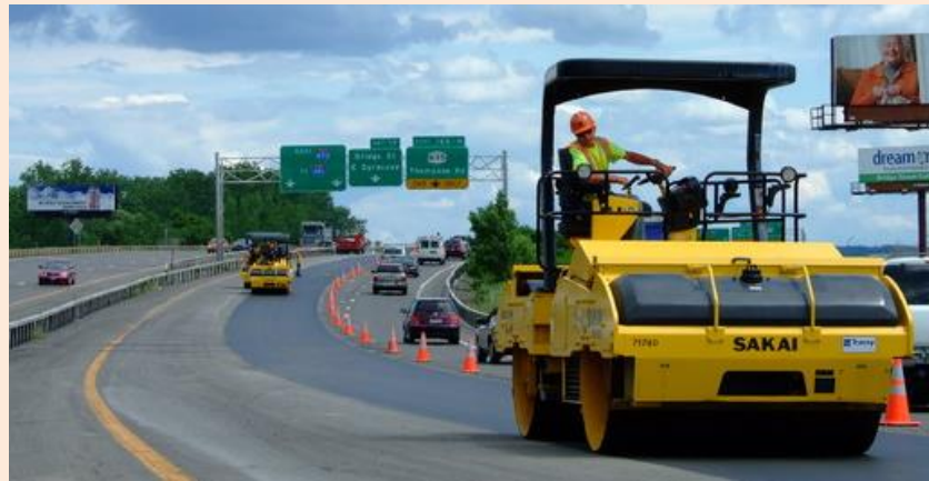
大型舗装用振動ローラ
