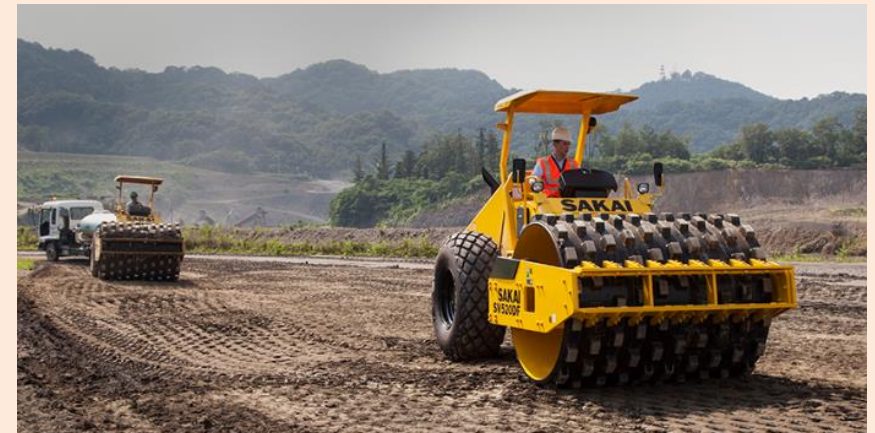
大型土工用振動ローラ
