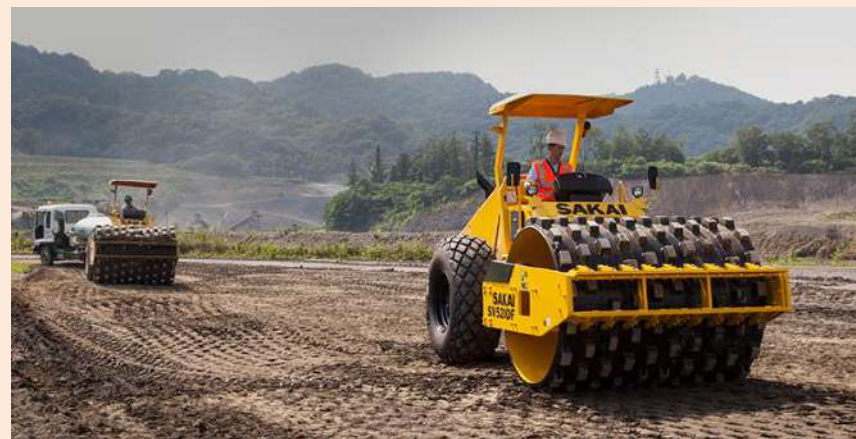
大型土工用振動ローラ
