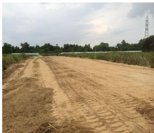
着工したスマトラ高速道路の現場
