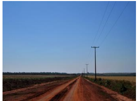
赤土の未舗装道路
